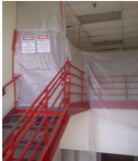
Asbestos Abatement – Bldg 524
